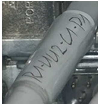
Abbildung 9: Beispiel einer Kabelbeschriftung mit dem angewendeten Beschriftungskonzept.
